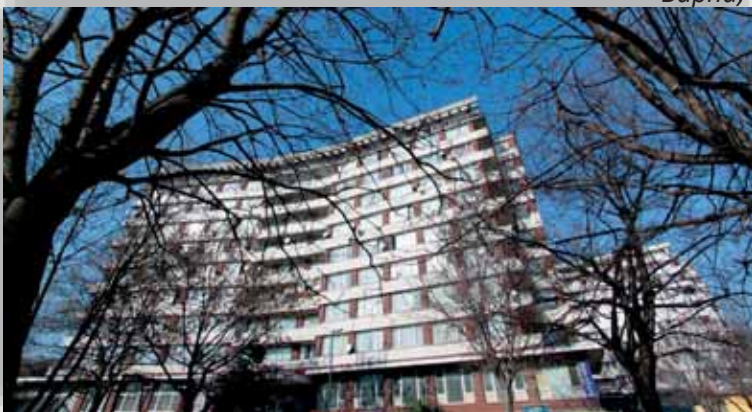
Ремонт и модернизиране на студентското общежитие на МУ-Варна, осъществени по проекта
